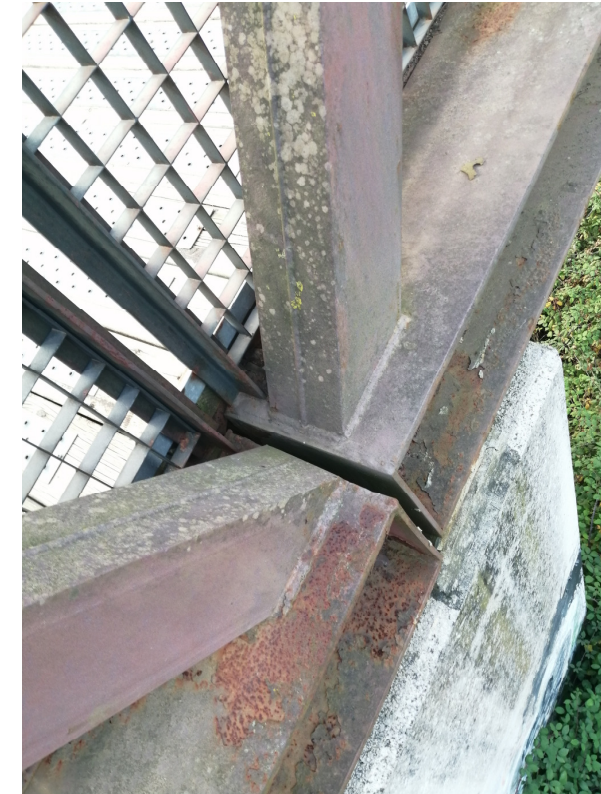
Perfil HEB 300 inferior i diagonals 2UPN 160
