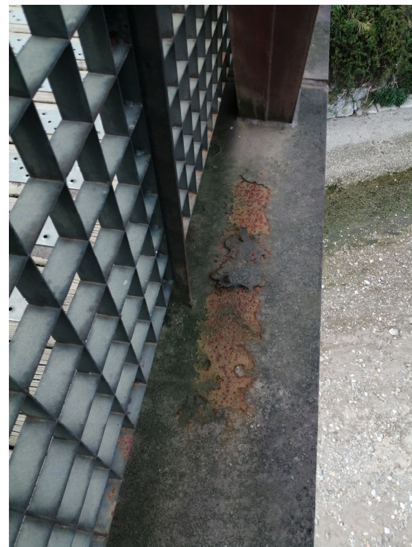
Perfil HEB300 inferior i barana
