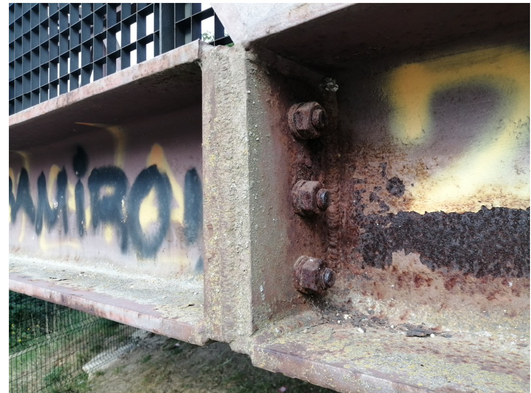
Perfil HEB300 inferior. Perns de connexió
