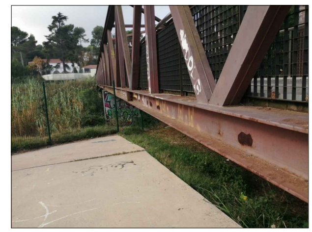
ESTRUCTURA METÀL·LICA: PINTURA ESCROSTONADA CORROSIÓ SUPERFICIAL i/o AMB LAMINACIÓ
