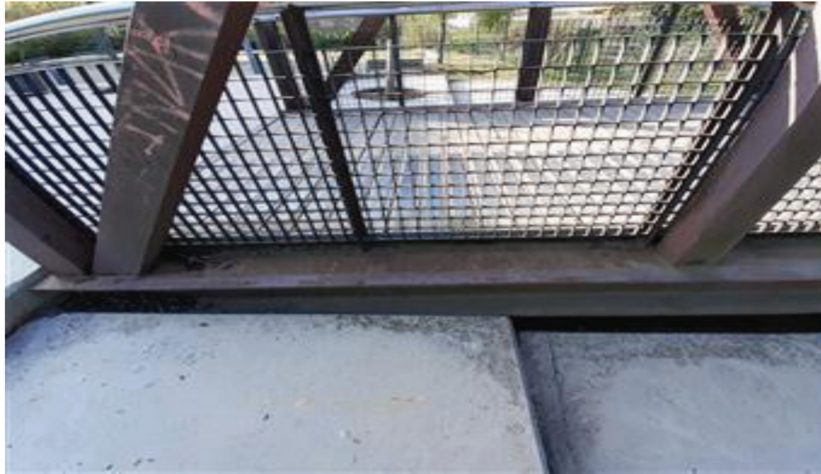
Vigas principales inferiores HB300 lado A y B Exterior
