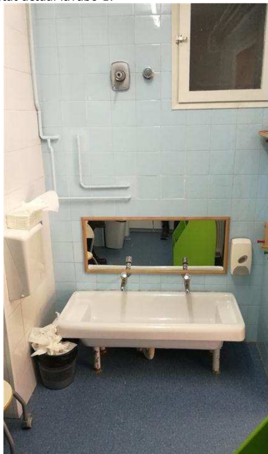
Estat actual lavabo 1:
