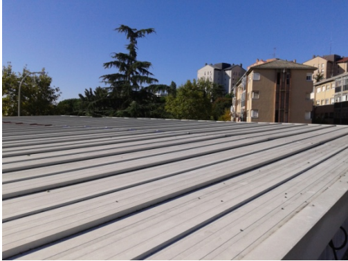
Foto 5. Detall de la coberta metàl·lica de l'edifici
