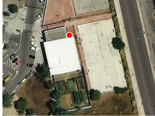
Foto 6. Ortofoto de les cobertes. Detall del punt d'accés. Font: Mapa de Protecció Civil de Catalunya
