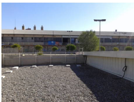
Foto 3. Detall de la coberta plana amb baranes autoportants. Vista Est
