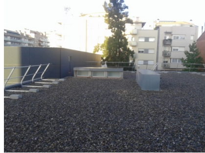
Foto 4. Detall de la coberta amb baranes autoportants i accés a pati tècnic.
