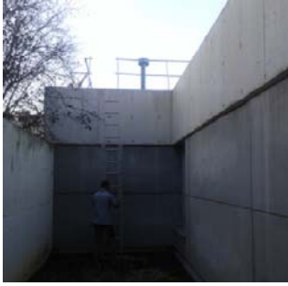
Foto 3. Detall de l'accés actual a la coberta amb escala manual
