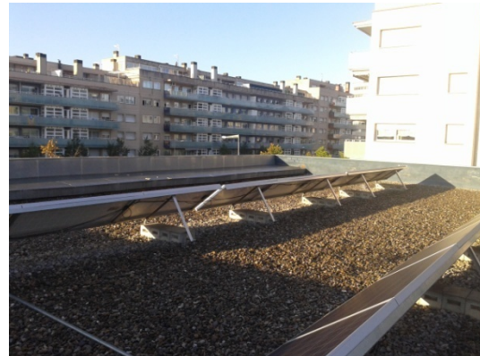
Foto 6. Detall de la coberta de la sala d'actes.
