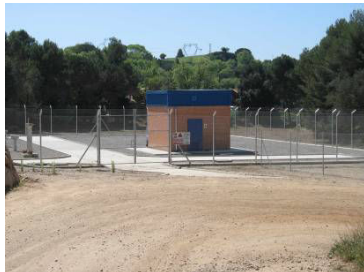
Centre posició de vàlvules del gaseoducte
