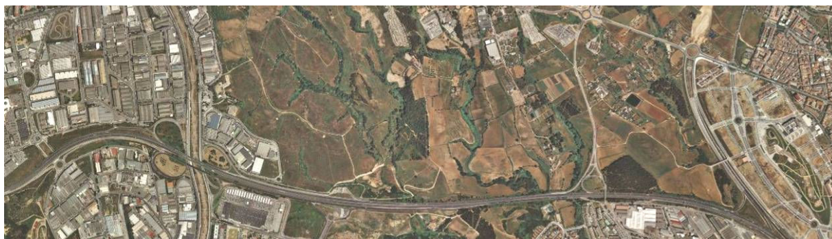
Connector nord-sud a l'alçada de la C-58
