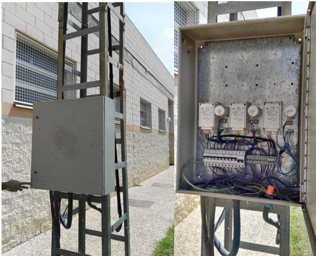
El comptador elèctric i el quadre general es troba en un recinte a l'esquerra de la grada. En el quadre general trobem les proteccions de les línies de les tres estructures metàl·liques (torres) de darrera la grada (3 ud 5x10mm<sup>2</sup>) i del subquadre de la zona de vestidors (4x25+16mm<sup>2</sup>). El cablejat de les tres estructures metàl·liques de darrera les grades és lliure d'halògens i s'ha substituït recentment.
