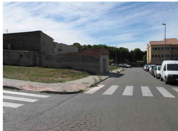
Cantonada Rioja amb Baracaldo, edificacions fora d'ordenació
