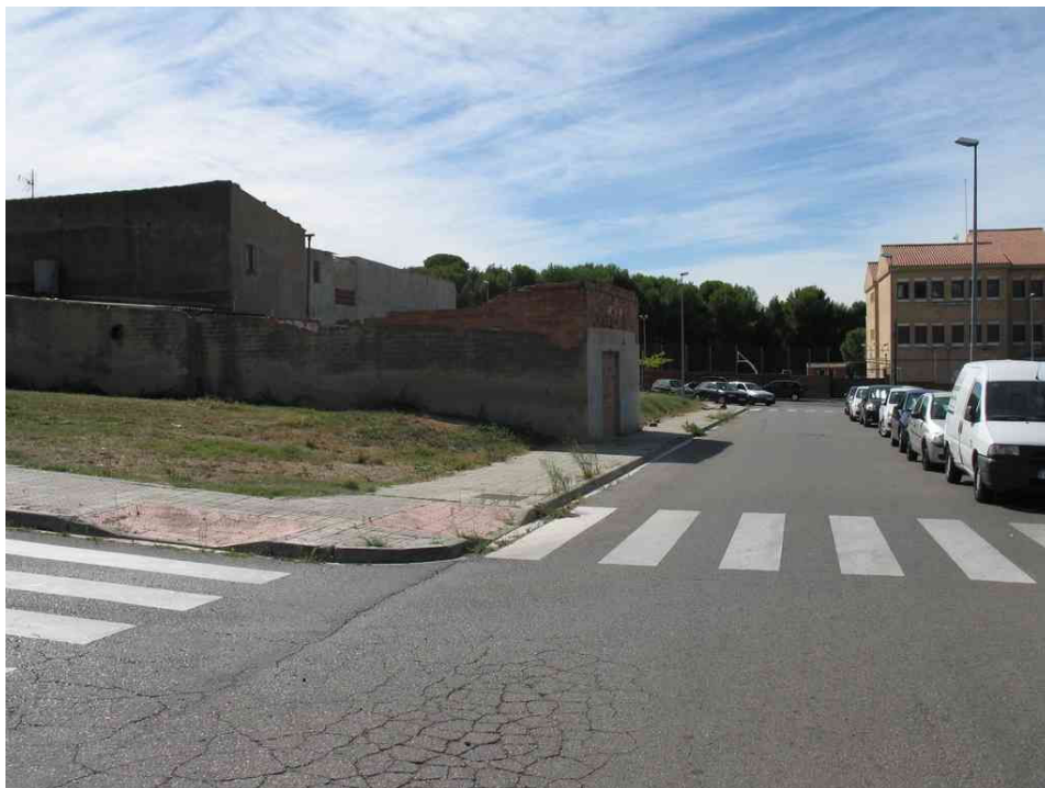
Cantonada Rioja amb Baracaldo, edificacions fora d'ordenació
