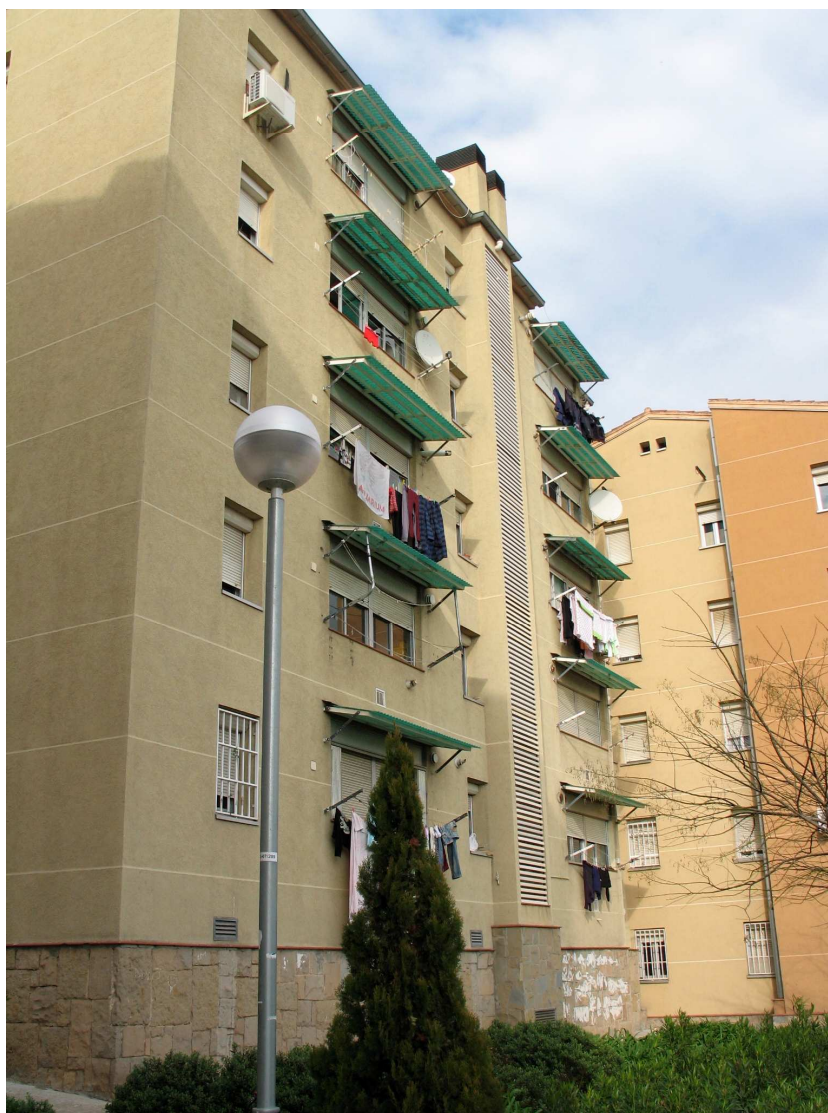
bloc 9, façana est.
