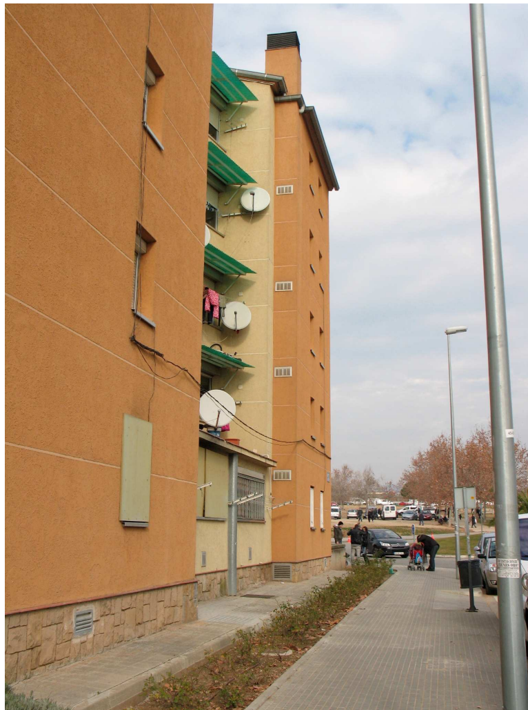
Bloc 15. Façana est.
