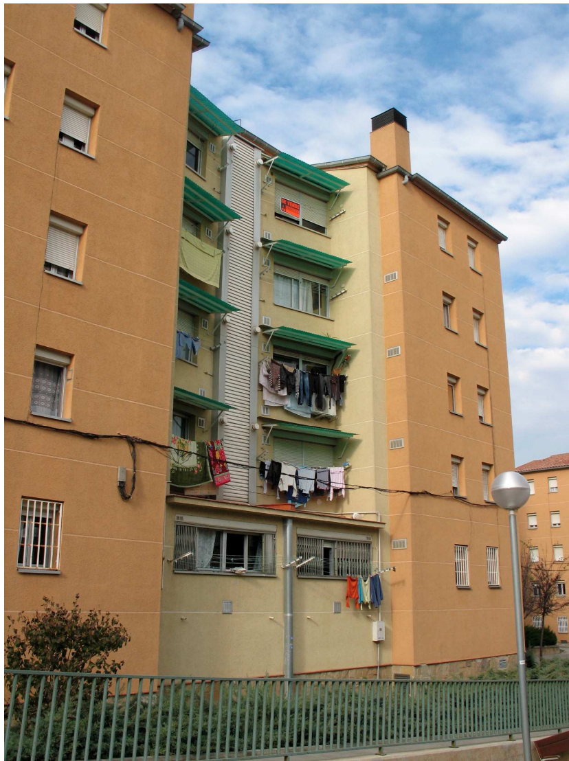
bloc 32, façana est
