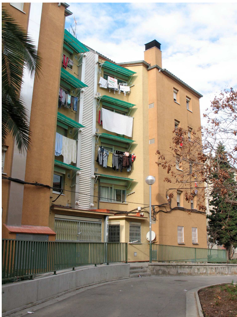
bloc 40, façana est
