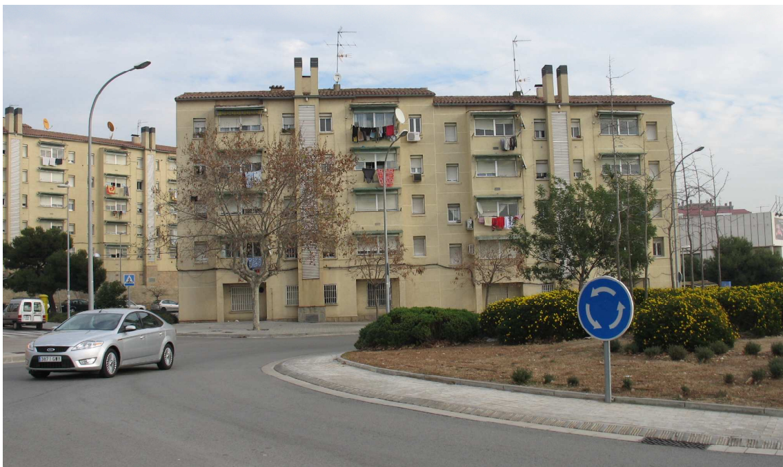
nova rotonda de la carretera de Montcada.
